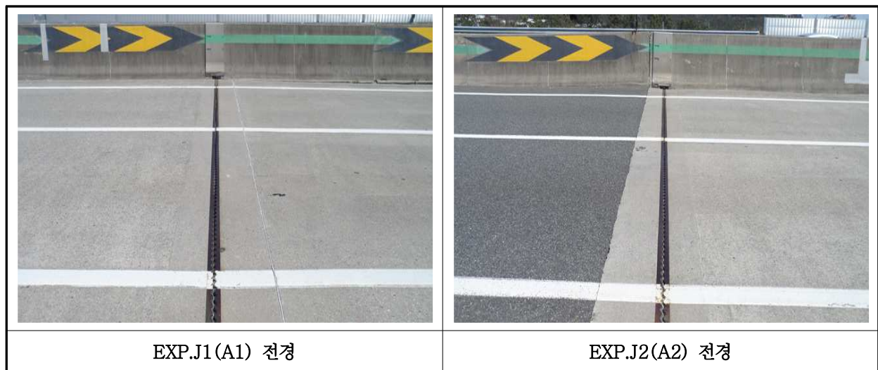
【사진 11.3.17】 신축이음장치 전경
