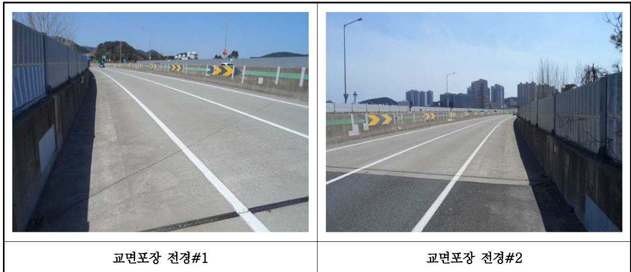
【사진 11.3.20】 교면포장 전경
