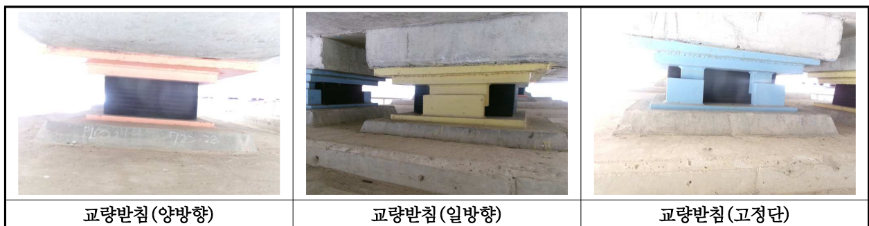
【사진 11.3.13】 교량반침 전경
