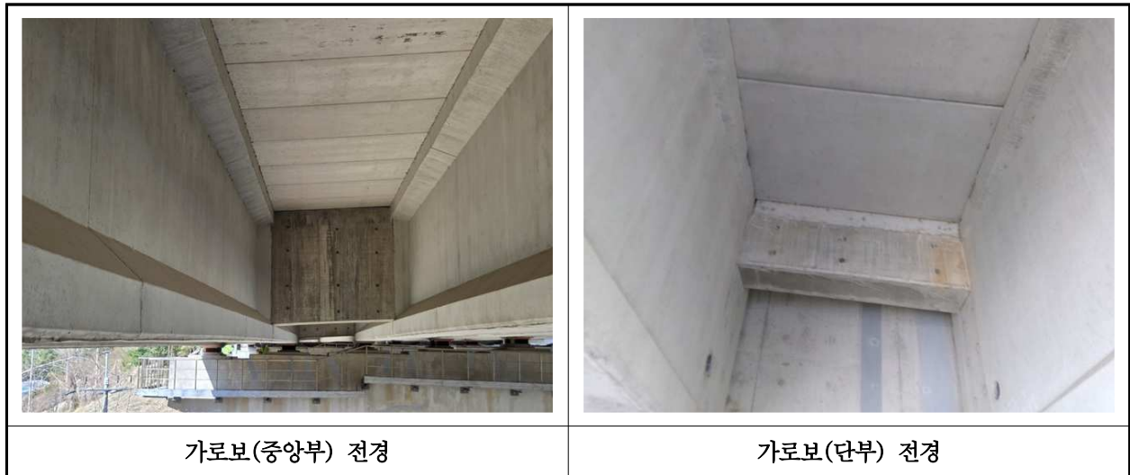
【사진 11.3.6】 가로보 전경
