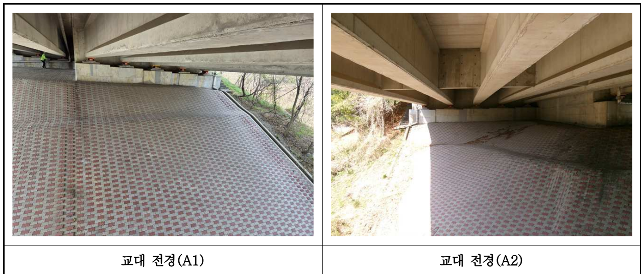
【사진 11.3.8】 교대 전경
