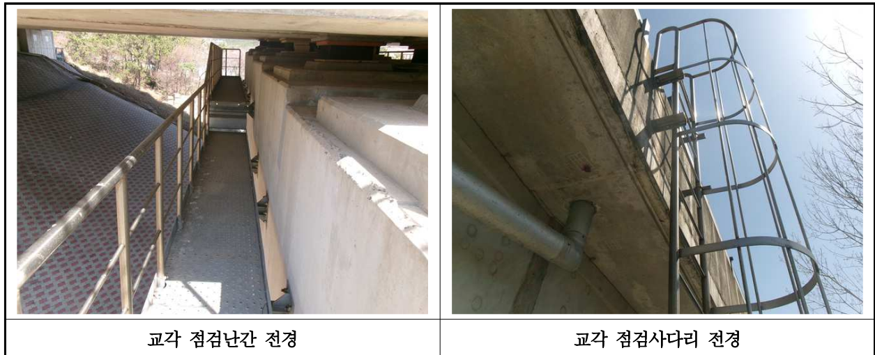
【사진 11.3.26】 교량 점검시설 전경
