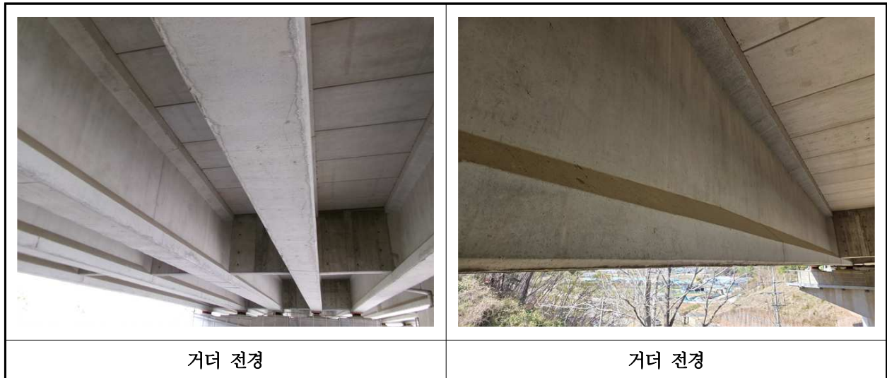
【사진 11.3.4】 거더 전경
