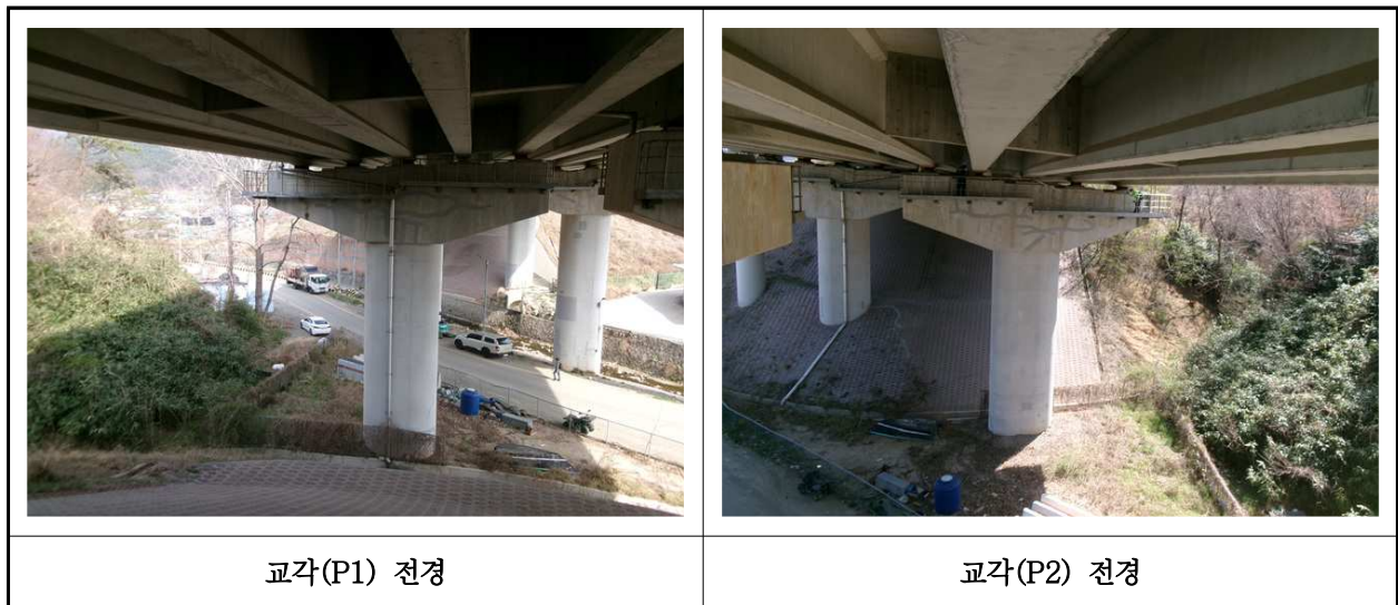
【사진 11.3.10】 교각 전경
