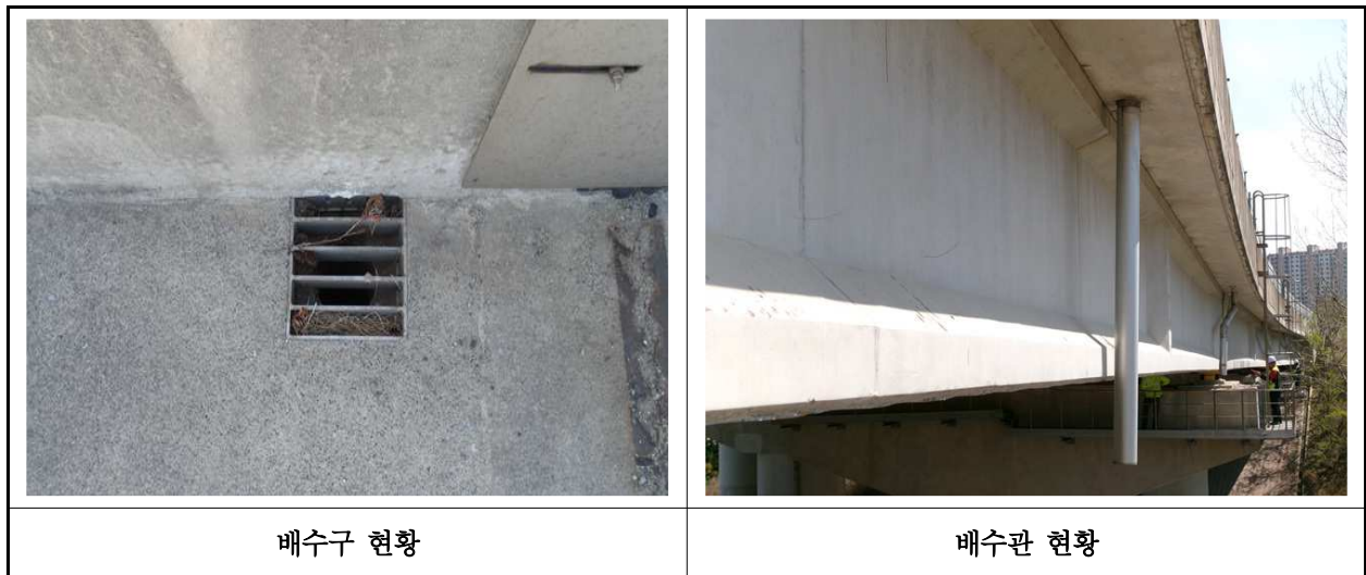
【사진 11.3.22】 배수시설 전경
