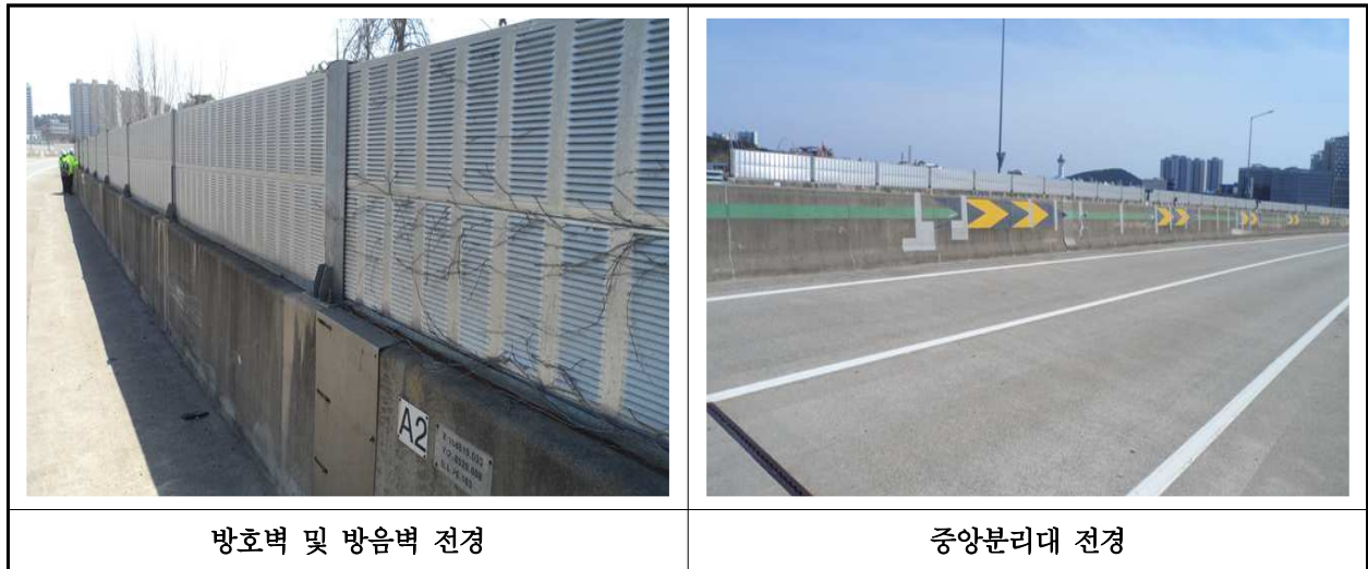
【사진 11.3.24】 방호벽 및 중분대 전경
