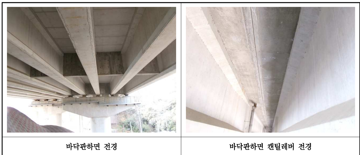
【사진 11.3.2】 바닥판하면 전경
