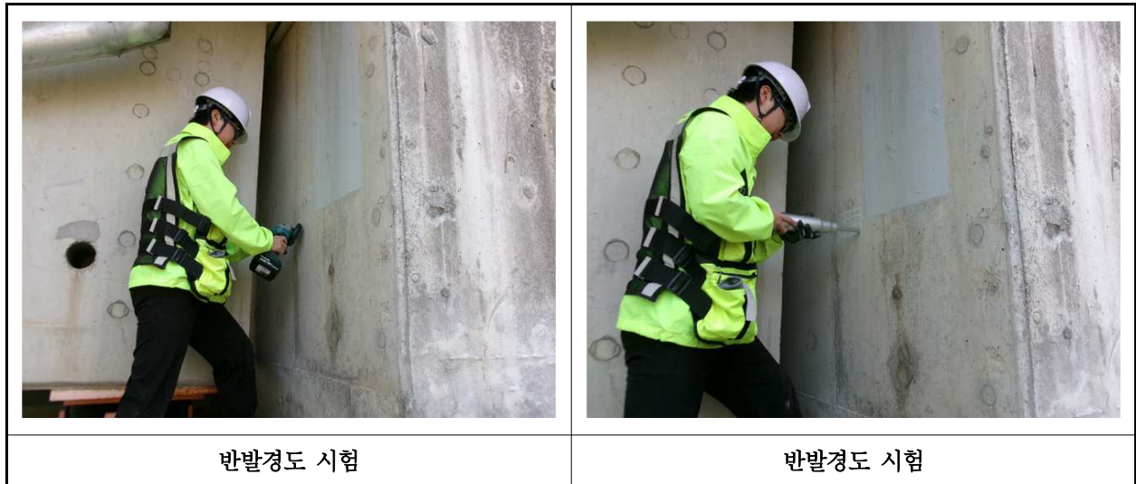
【사진 11.4.2】 반발경도시험 현장사진
