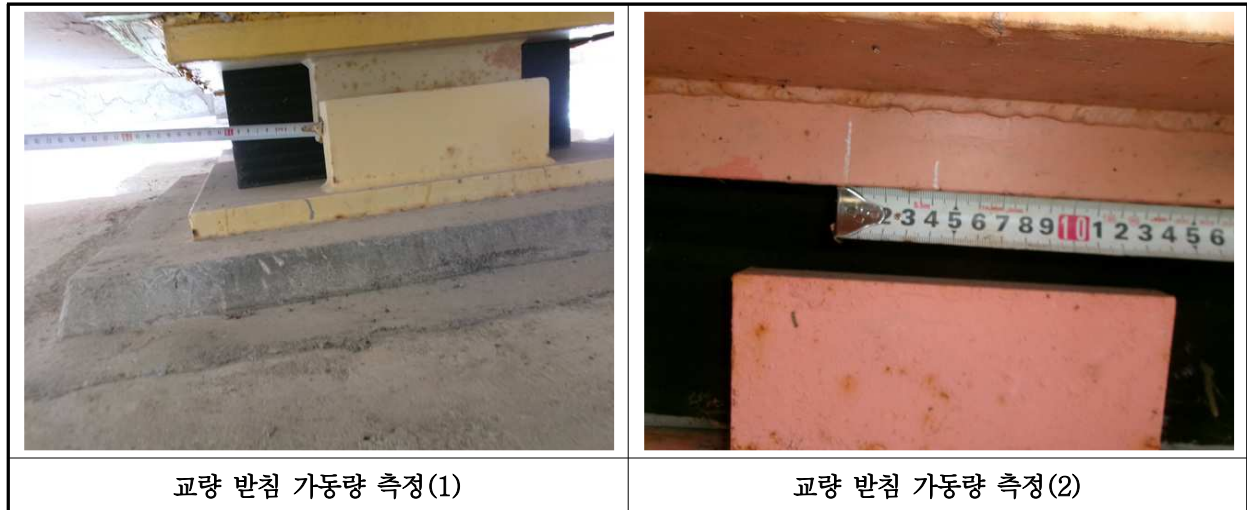
【사진 11.3.16】 교량받침 이동량 측정
