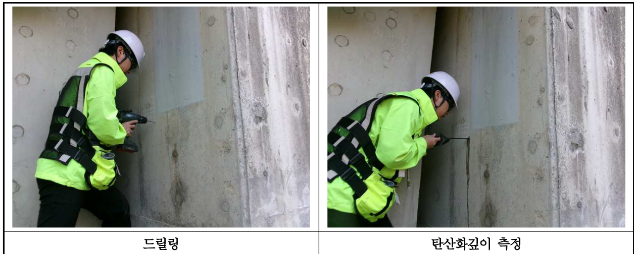
【사진 11.4.3】 탄산화 깊이 측정 현장사진
